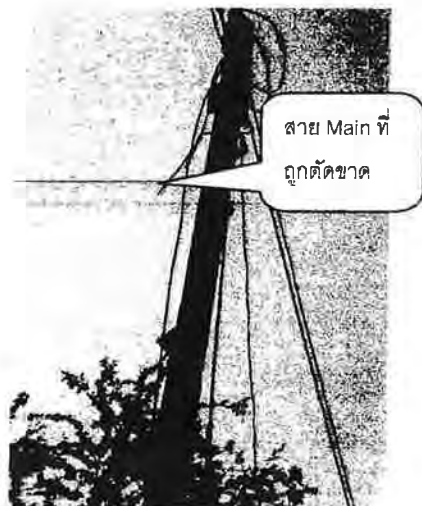
รูปที่ 3 สายไฟฟ้า Main จากการไฟฟ้าภูมิภาคก่อนเข้ามิเตอร์ตรวจวัดถูกตัดขาด
