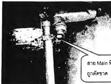
รูปที่ 2 สายไฟฟ้า Main ถูกตัดขาดก่อนเข้าสู่สถานี
